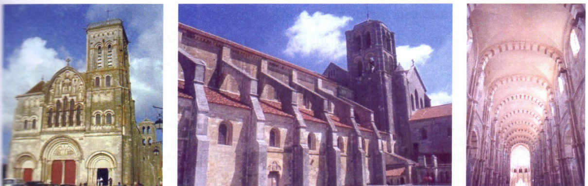
Figura 7: Vistas externas e interna da Basilique de la Madeleine at Vézelay, de Viollet-le-Duc. Fonte: http://www.structurae.net/files/photos/64/vezelay01.jpg , egl9a.jpg e egl17a.jpg.
