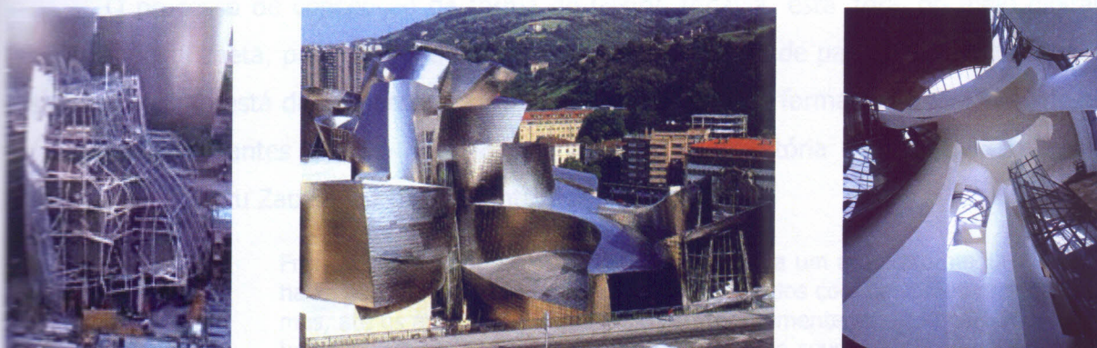
Figura 11: O museu Guggenheim de Bilbao: processo construtivo e obra acabada. Fonte: ACHTEN, 200, STEELE, 2001, p. 128 e p. 126.
