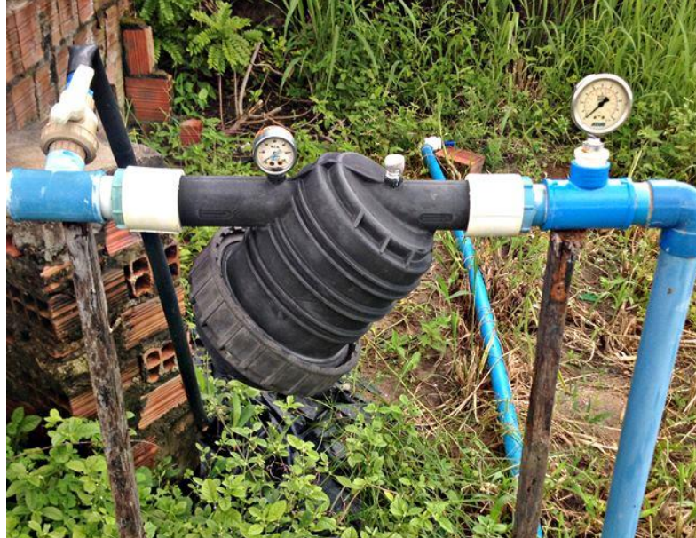
Figura 5 - Cabeçal de controle com filtro, Fortaleza, Ceará, 2021.
