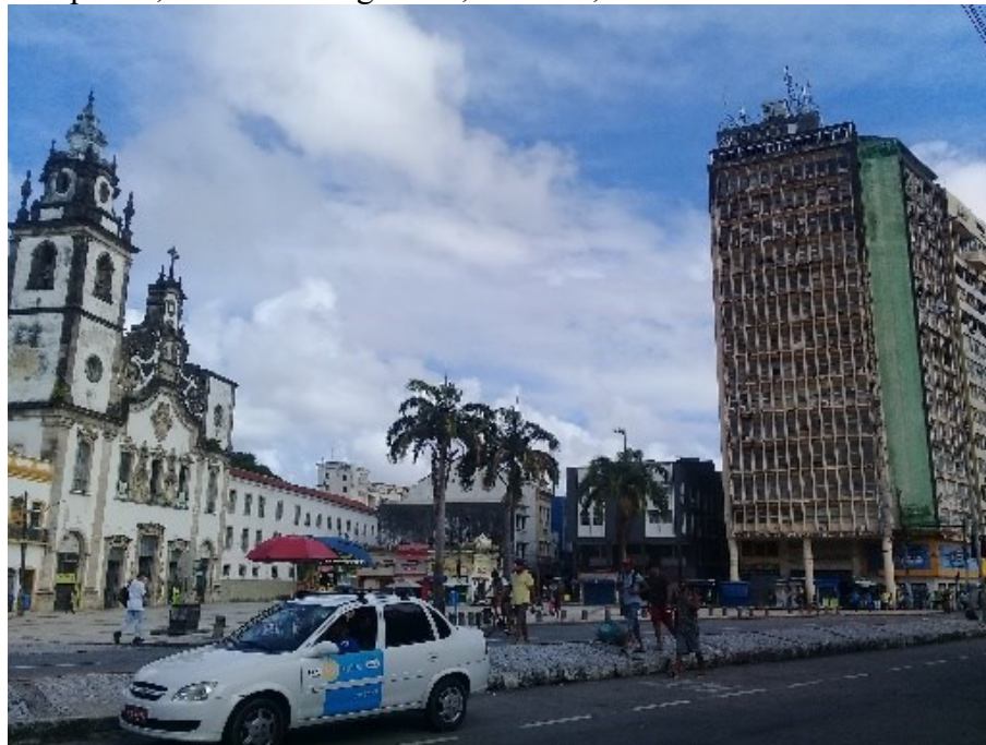
Figura 20 – Largo do Carmo partido ao meio pela Av. Dantas Barreto, vendo-se seu leito carroçável à frente na imagem, a igreja homônima, à esquerda, e o Edifício Igarassu, à direita, em Recife.
