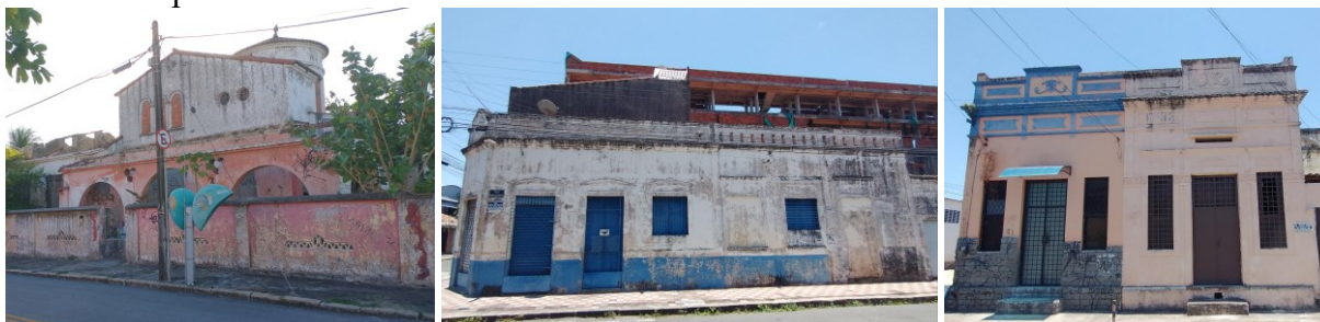
Figura 91 – Imóveis excluídos da delimitação da ZEPH Jacarecanga pela Câmara. 257
