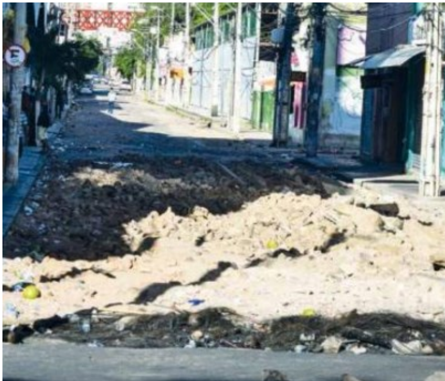
Figura 9 – Início da demolição do pavimento da Rua José Avelino pela PMF.
