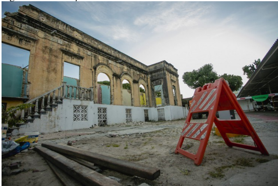
Figura 8 – Demolição do Casarão dos Gondim.
