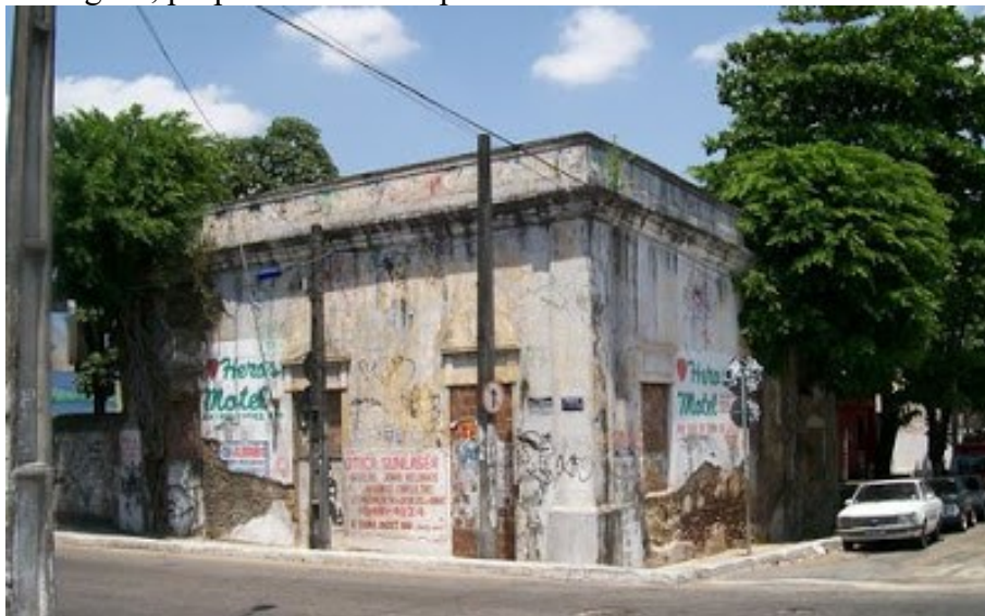
Figura 3 – Casa de Câmara e Intendência da Vila de Arronches, Parangaba, propriedade municipal.
