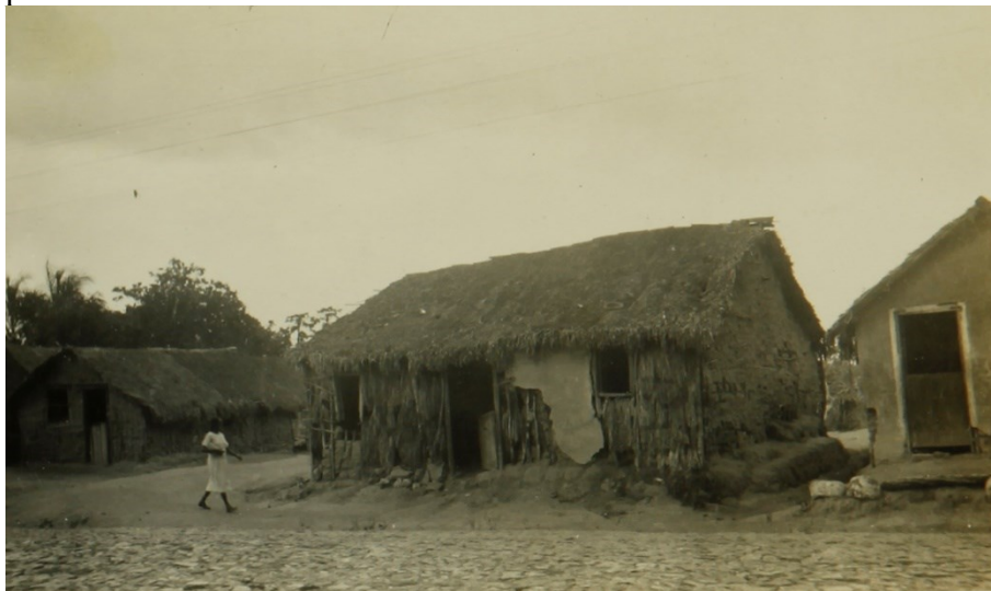
Figura 13 – Cabana de pau-a-pique e cobertura de palha, provavelmente em uma das estradas de acesso a Fortaleza.
