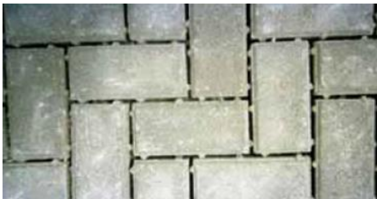
Figura 11 – Espaçadores de juntas nos pavers
