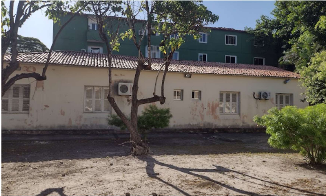
Figura 6 – Fachada lateral da CCI.
