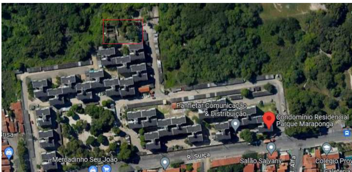
Figura 29 — Local de instalação com destaque da ETE.
