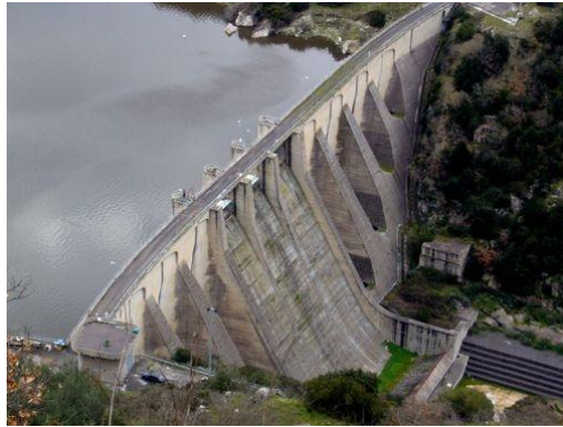
Figura 1 – Barragem de concreto.
