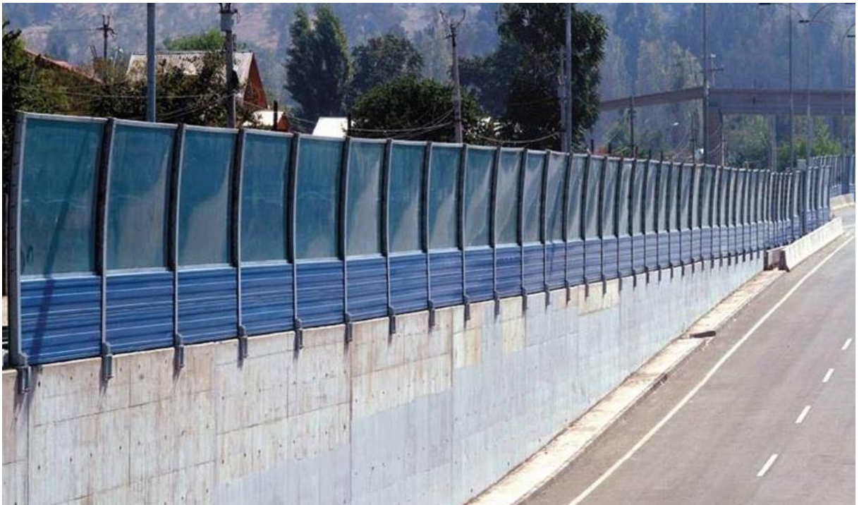
Figura 7 - Barreira acústica em rodovia no Chile
