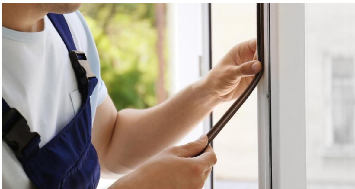
Figura 30 - Substituição das borrachas de vedação para esquadrias de alumínio
