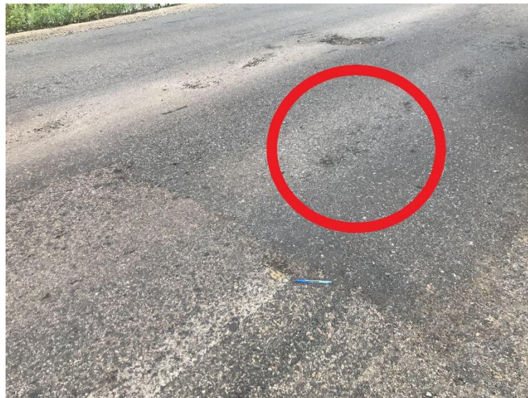
Figura 18 – Remendo profundo em parte do trecho.
