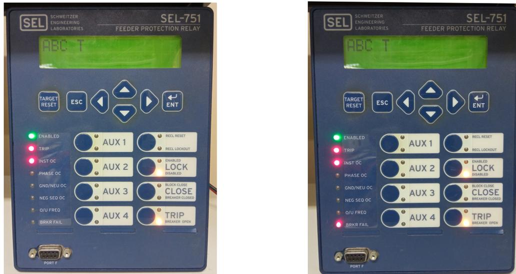
a) Situação sem falha de disjuntor.
