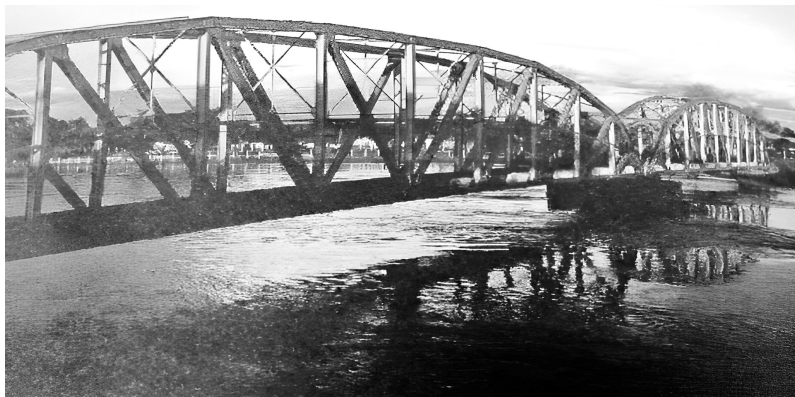
Figura 1 – Ponte metálica sobre o Rio Jaguaribe
