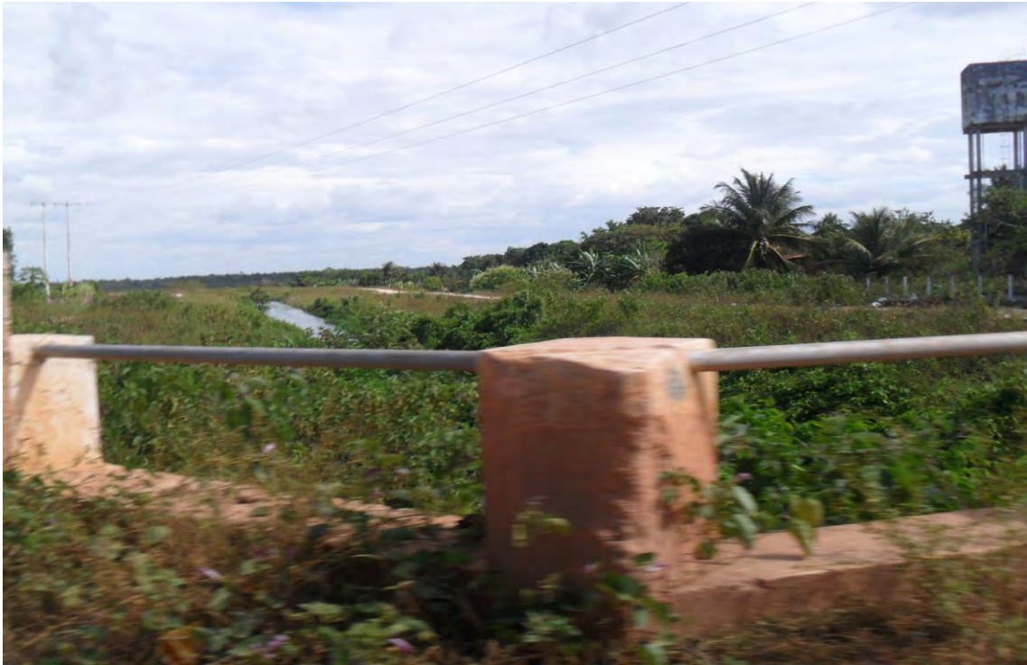
Figura 23. Fotografia do canal do trabalhador. Foto: Marlene P. Santos, 2012.
