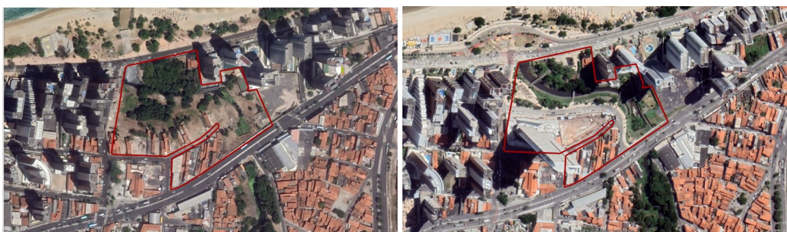
Figura 16: À esquerda, ocupação informal nas proximidades da foz do riacho Maceió (2012) à direita, implantação do Parque do Riacho Maceió, já com o edifício em construção (2020)
