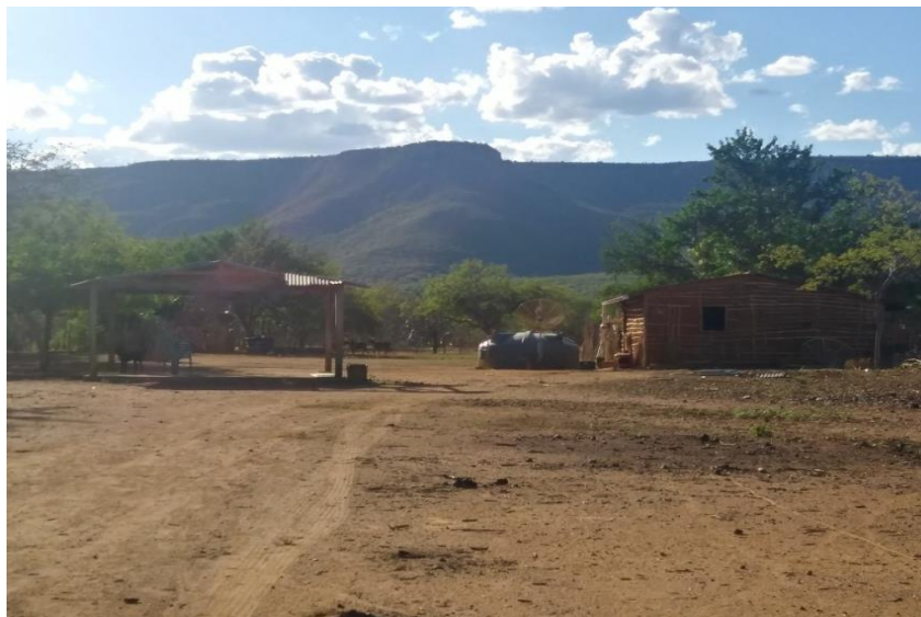
Figura 7 – Edificação atingida pelo traçado inicial. Coordenadas: 321822 / 8919968.
