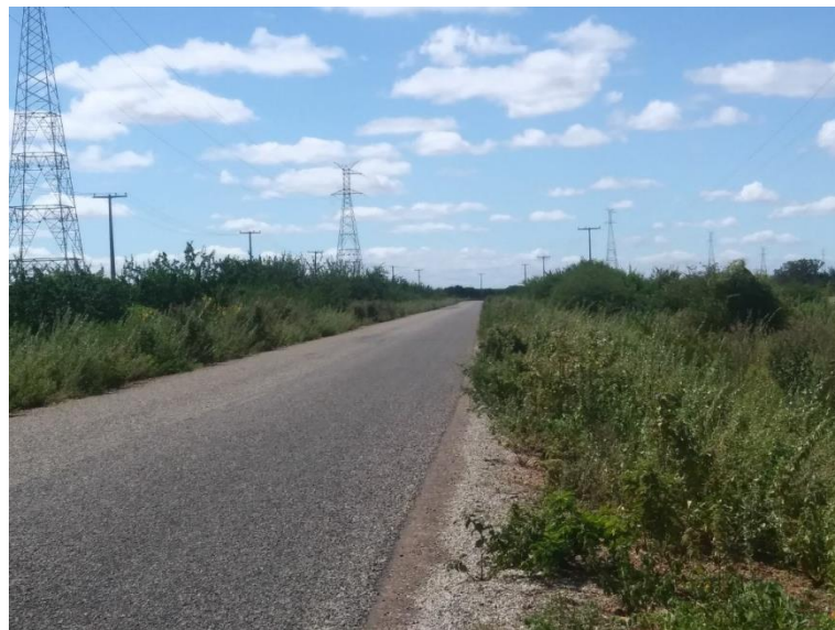
Figura 19 – Rodovia BR-122 (Ao fundo LT 230kV Delfina / Juazeiro).
