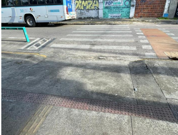
Figura 23 - Rampa de acesso
