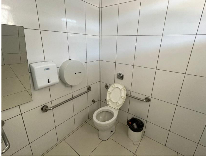
Figura 17 - Sanitário banheiro acessível
