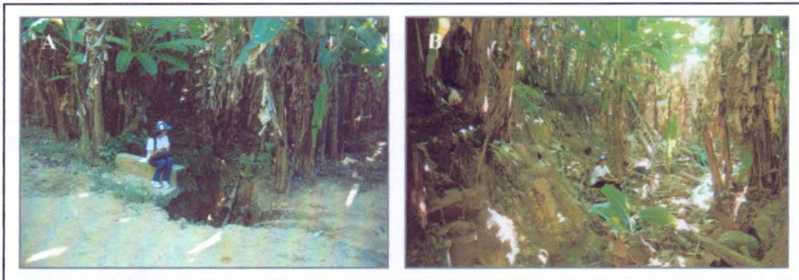
Foto 5.2 – A) Condutor de água sendo destruído pela erosão. B) Plantação de bananeira no leito de uma drenagem deixando o solo totalmente vulnerável, assoreando o rio devido a retirada da vegetação nativa e acelerando o processo erosivo.
