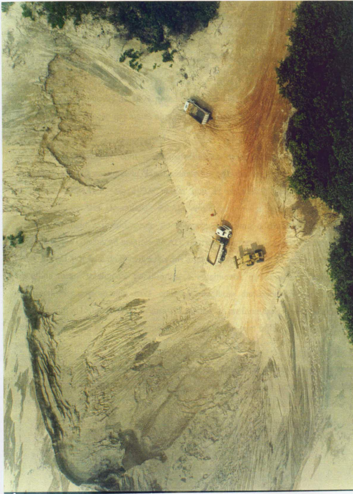
Figura 9.8 - Fotografia evidenciando o desmonte de duna móvel. Porém, constata-se que o caminho de acesso foi implantado em área considerada pela legislação como de preservação (reserva ecológica). Ressalte-se que a extração nesta área é considerada de risco potencial, sobretudo por tratar-se de dunas móveis e pela verticalização dos taludes. Área de interesse da IMPROL.
