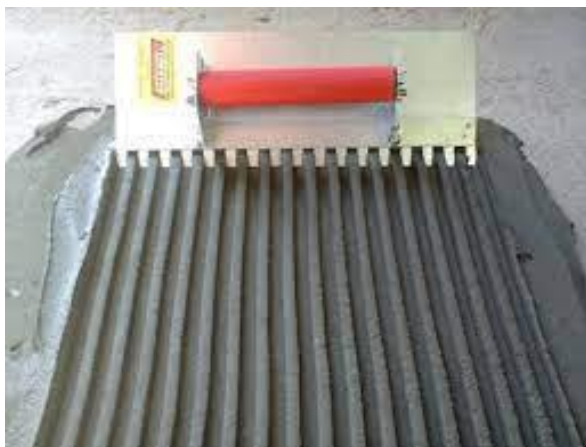
Figura 8 - Espalhamento da argamassa colante na camada de contrapiso
