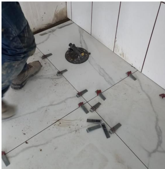
Figura 13- Placa cerâmica assentada com ventosa na obra A
