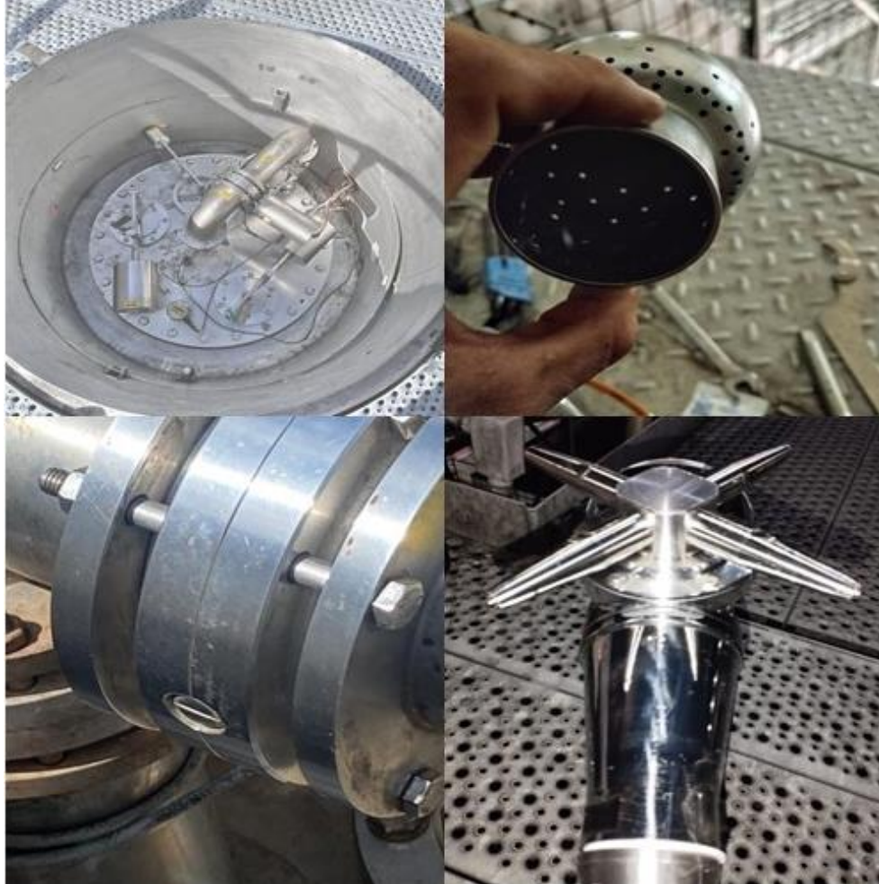
Figura 13 – Execução de Check de aspersores e de comutação de válvulas
