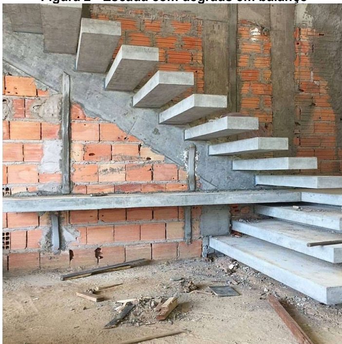
Figura 2 - Escada com degraus em balanço
