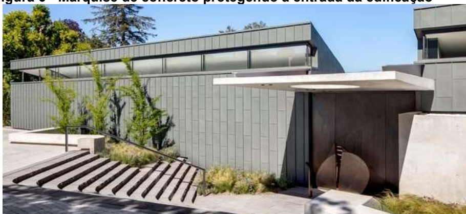
Figura 6 - Marquise de concreto protegendo a entrada da edificação
