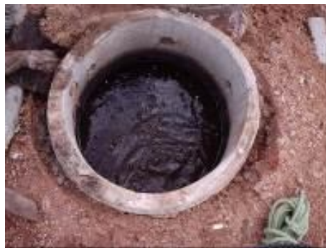
Figura 1. Drenagem de gás completamente tomado por chorume do ASMOC. Fonte: Carvalho Jr, F.H.(2011).
