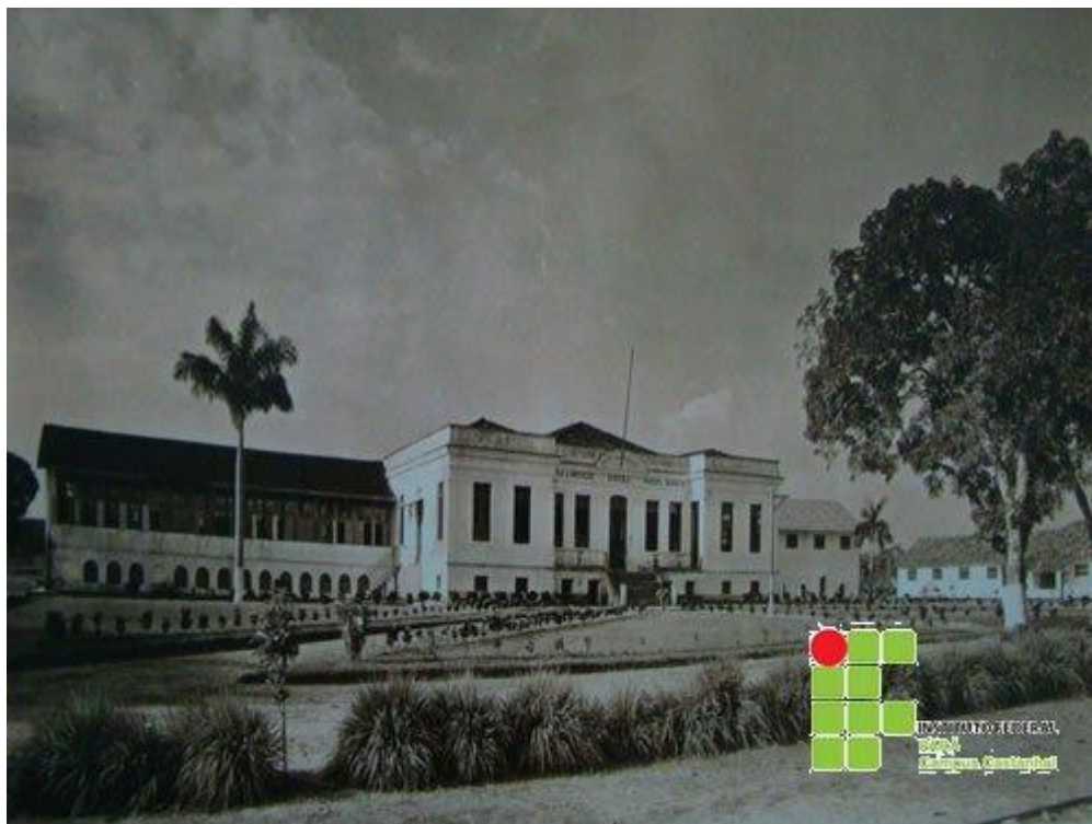
Figura 2 – ESCOLA DE INICIAÇÃO AGRÍCOLA MANOEL BARATA – OUTEIRO/PARÁ
