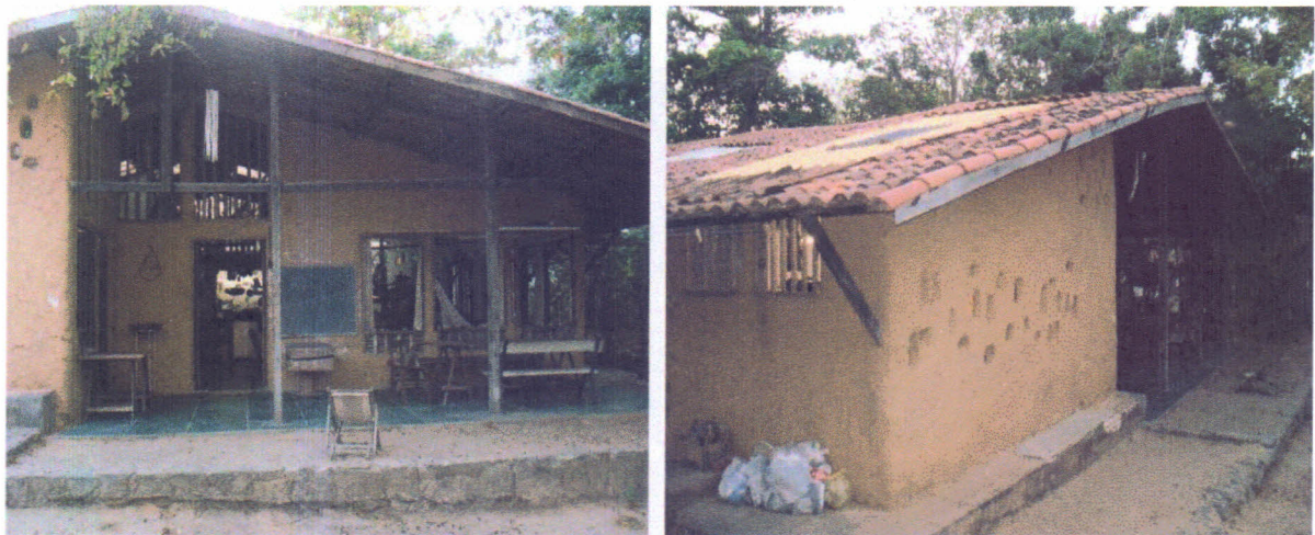
FIGURA 65 – Frente da Unidade 3, que se abre para dentro do terreno.
