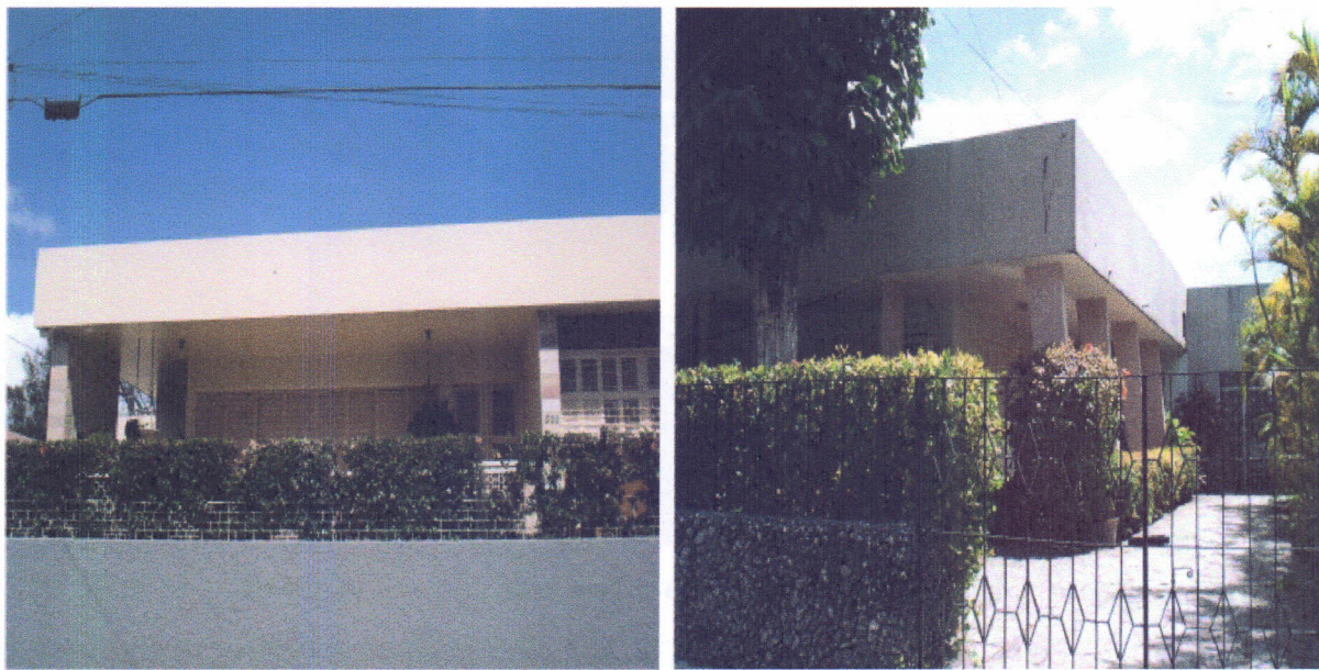
FIGURA 30 – Residências com princípios da “Arquitetura Moderna Brasileira” em Fortaleza.
