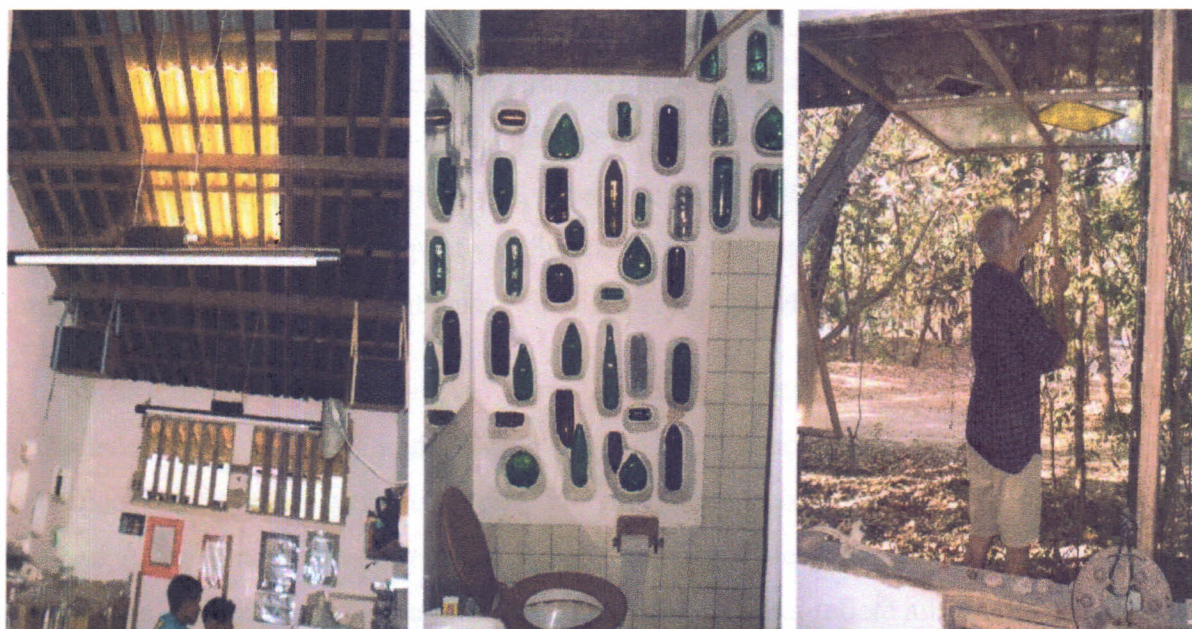
FIGURA 64 – Aberturas da Unidade 3. Iluminação zenital pelo telhado (esquerda), iluminação difusa nas paredes por vidro (centro), iluminação direta por janelas de canto (direita).
