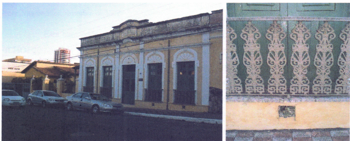
FIGURA 36 – Fachada da Unidade 1 e detalhe de balcão de ferro (direita).
