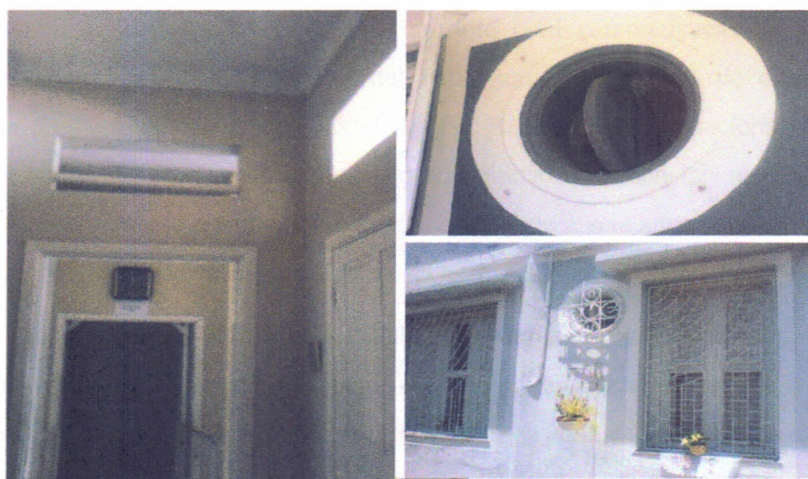
FIGURA 59 – Aberturas da Unidade 2: aberturas internas (esquerda), óculos (direita superior) e janelas retangulares com gradis (direita inferior).
