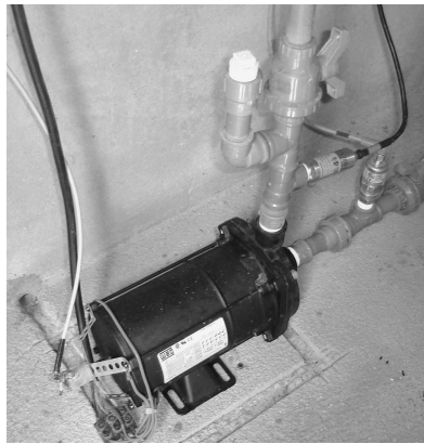
Figura 8 – Conjunto motor – bomba centrífuga e sensores alimentados pelo sistema de energia eólica
