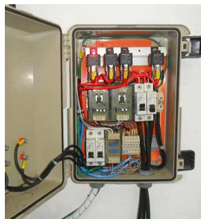
Figura 8 – Interface de Controle de Carga.
