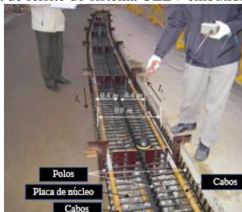
Figura 20 - Trilha de ferrite do sistema OLEV embutida na estrada
