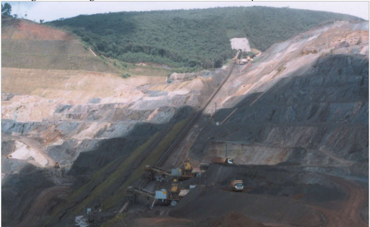
Figura 11 – Britagem Dentro da Cava e Caminhões De Pequeno Porte No Minério.
