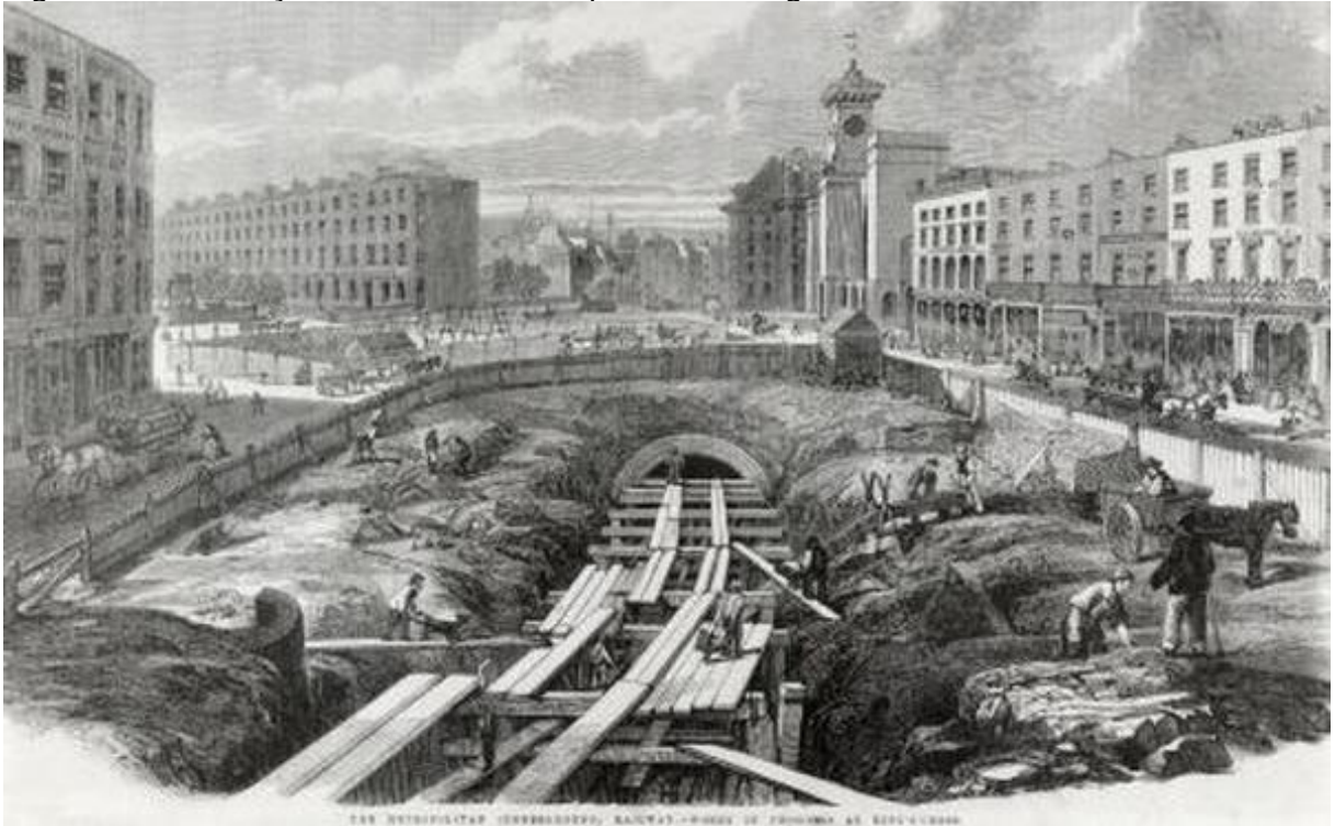
Figura 3 – Construção da linha de metrô próximo a King's Cross, Londres, 1860
