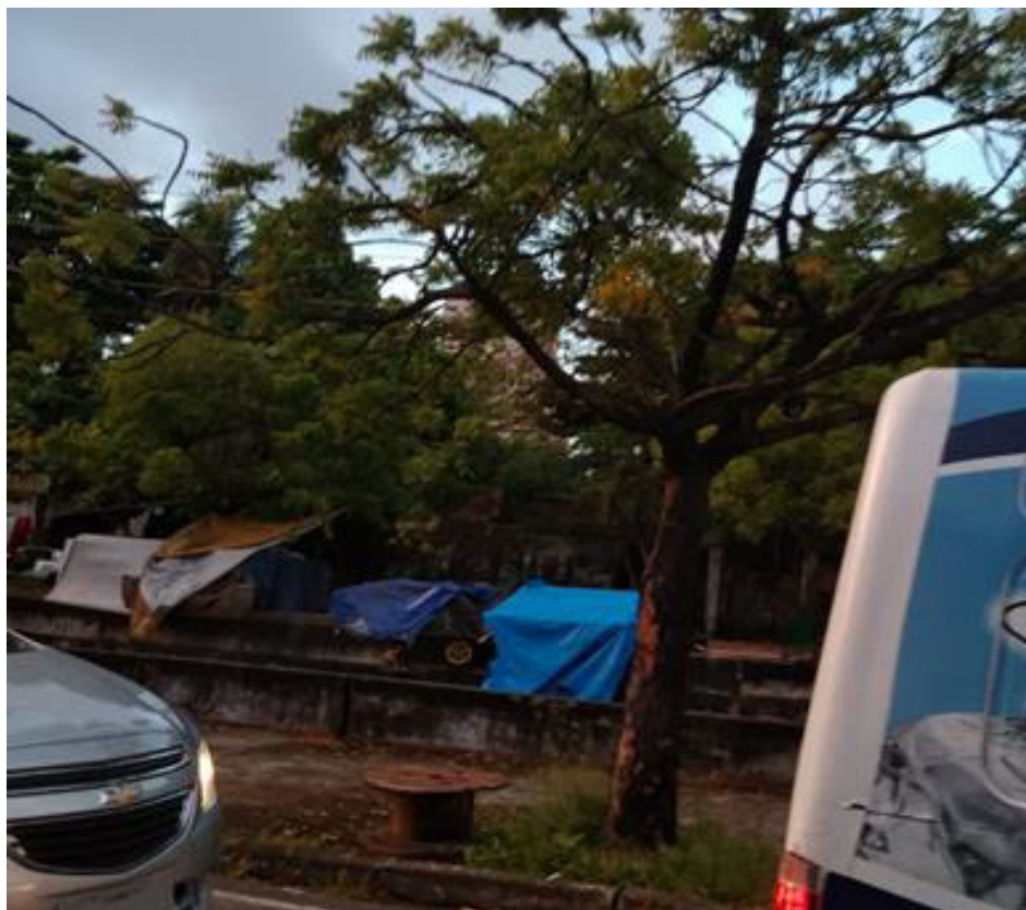
Figura 11 – Habitações Irregulares ao Longo do Canal da Avenida Eduardo Girão.
