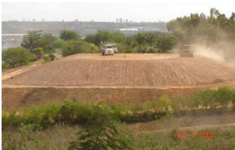
Figura 6 - Célula no Aterro Sanitário de Muribeca
