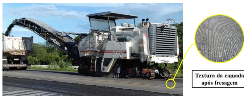
Figura 2 - Fresagem de pavimento
