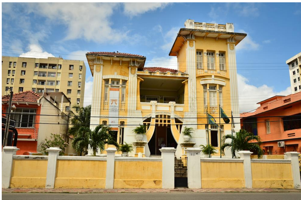
FIGURA 5 – FACHADA NORTE DA ESCOLA DE ARTES THOMAZ POMPEU SOBRINHO
