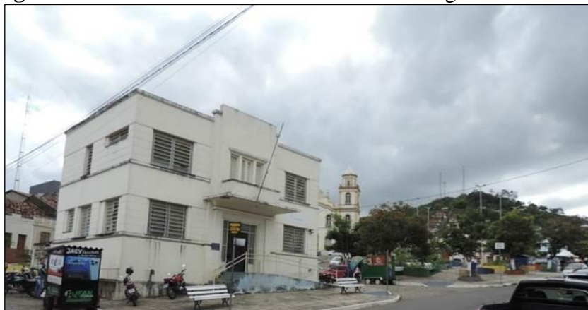
Figura 76 – Prédio dos Correios no centro de Alagoa Grande-PB.
