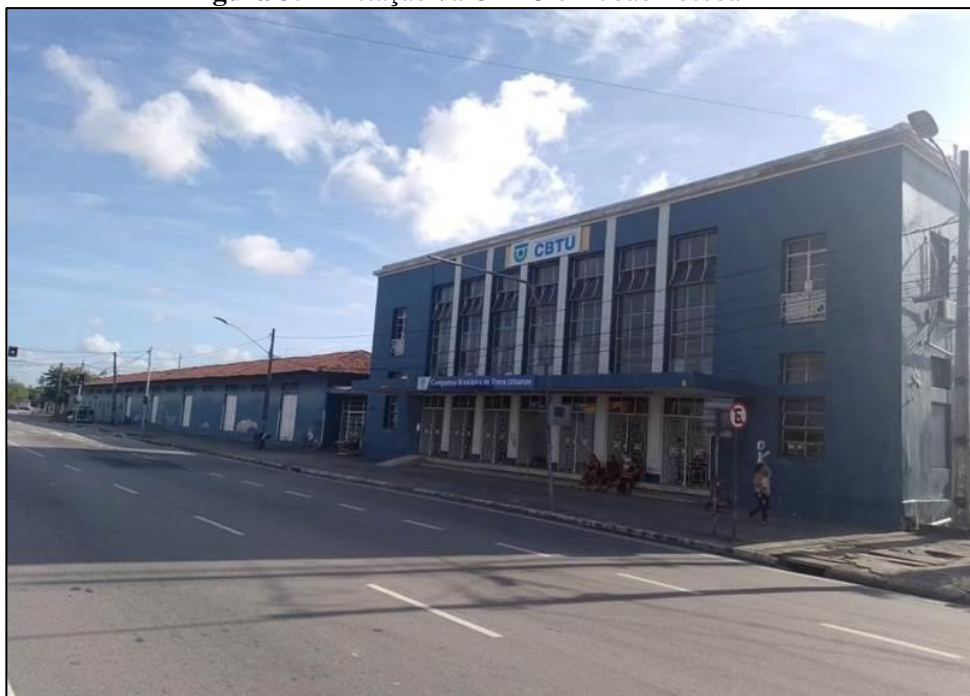
Figura 35 – Estação da CBTU em João Pessoa-PB
