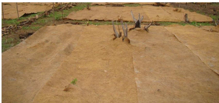
Figura 2 - Manta protetora de fibra de coco para manter a serapilheira nos tratamentos na área experimental no Município de General Sampaio – CE, 2008.
