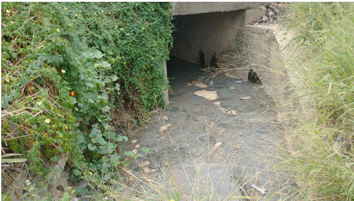
Figura 20 - Efluente doméstico em rede de drenagem
