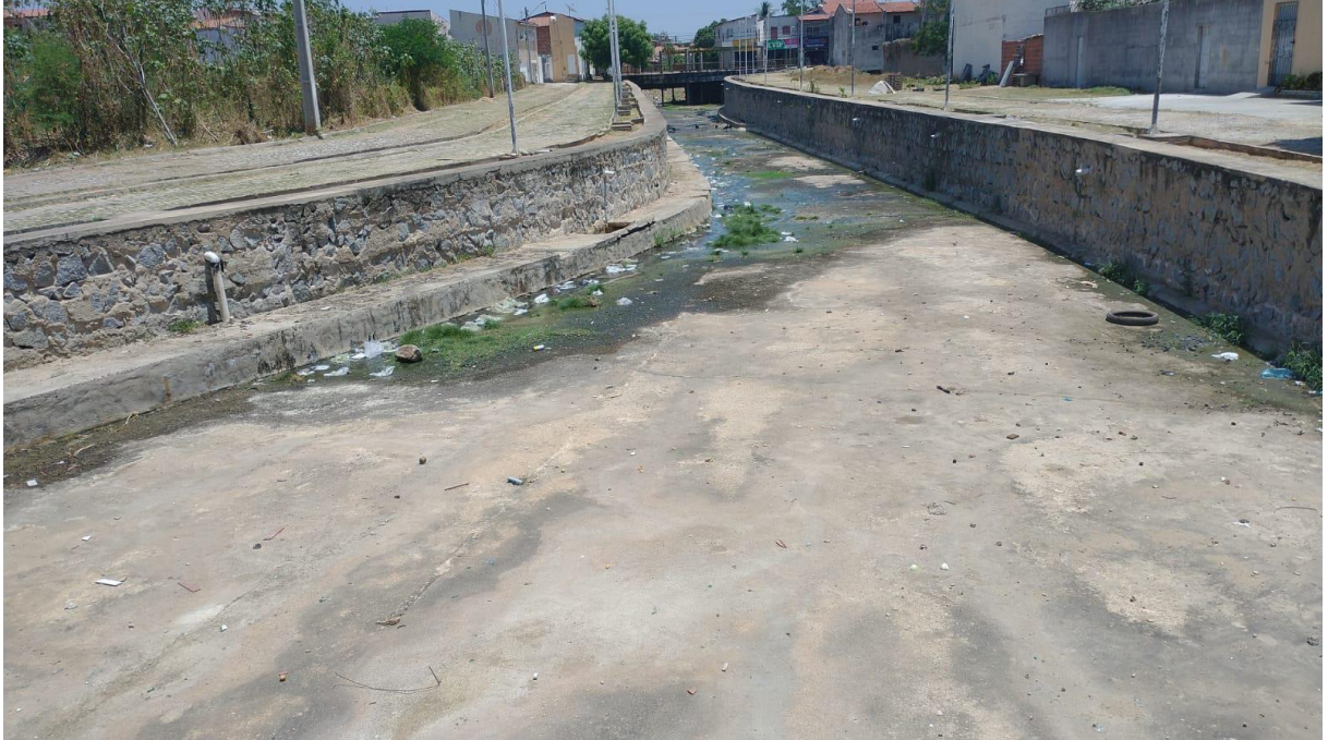
Figura 22 - Trecho impermeabilizado do Riacho da Palha
