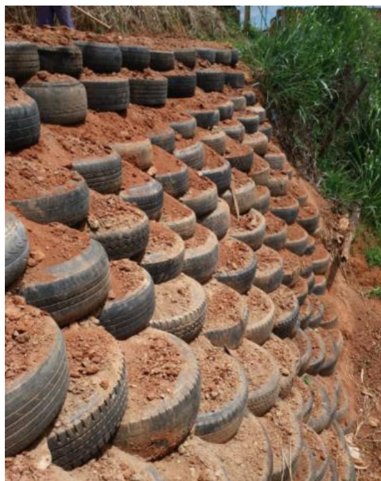
Figura 9: Encosta feita com pneus inservíveis
