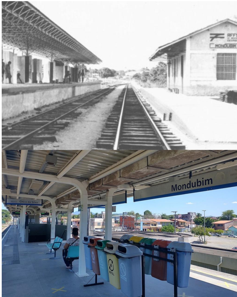
Figura 11 - Estação Mondubim - a de cima mostra duas edificações, a primeira à direita de tempos mais primórdios e a outra à esquerda na operação dos trens suburbanos (1980); já a de baixo é a estação totalmente reformada para o metrô (2020)
