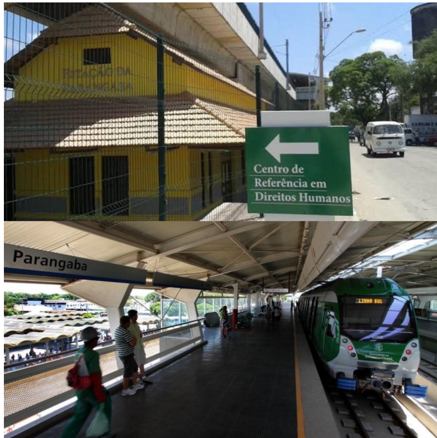
Figura 10 - Estação da Parangaba - a de cima a mais antiga preservada e tendo uma nova função, a de baixo a mais nova erguida para o novo sistema metroferroviário (2019).
