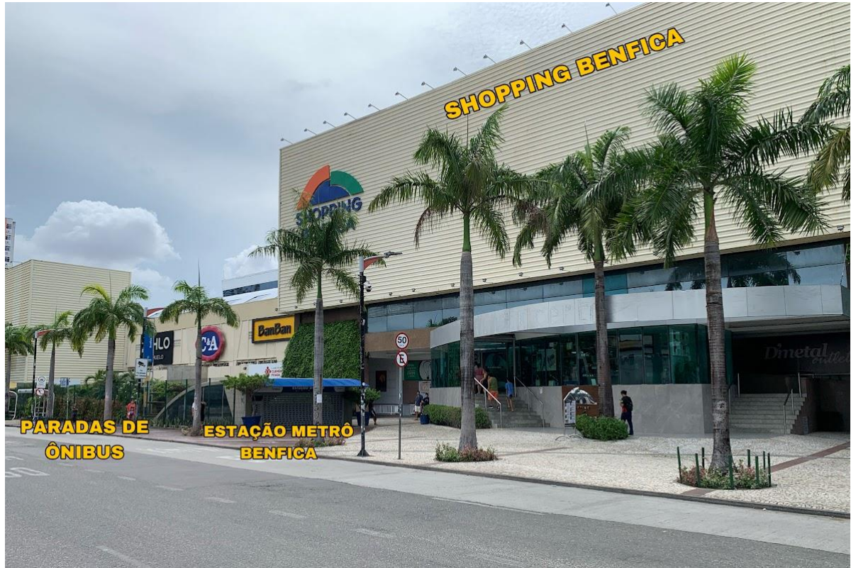
Figura 22 – Shopping Benfica, Estação do Metrô Benfica e Paradas de Ônibus na perspectiva da Avenida Carapinima.
