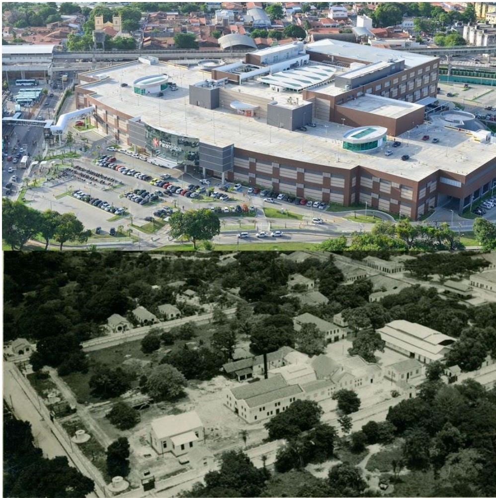
Figura 28 – Shopping Parangaba atualmente acima e Fábrica de Gesso Chaves abaixo.
