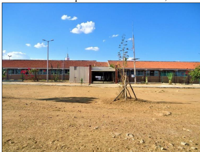
Figura 51 – Fachada da Escola do Campo Florestan Fernandes, Assentamento Santana, 2021
