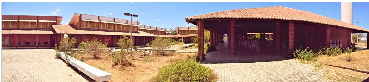
Figura 44 – Parte da estrutura física da EEM Florestan Fernandes, Assentamento Santana, Monsenhor Tabosa, Ceará
