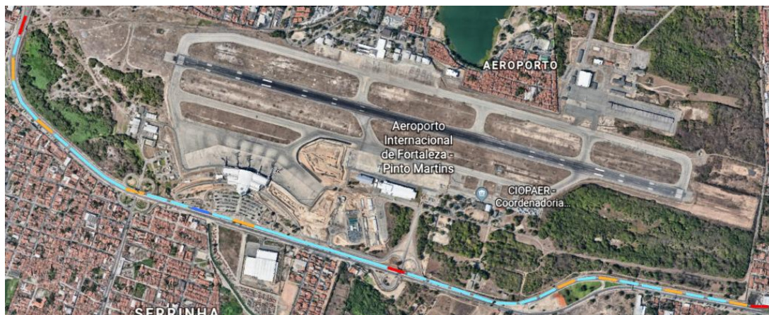
Figura 36 - Mapa gerado pelo Roadlab - classificação por cores (Faixa esquerda - sentido Montese) Rodovia CE-401
