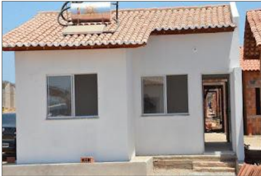
Figura 7 e 8. Registro de Casa do Residencial Monsenhor Montenegro, Crato/ CE com coletor solar.
