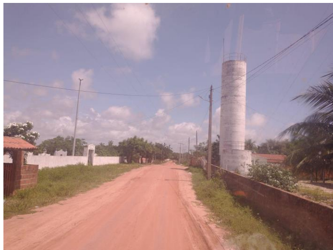
Figura 14 - Reservatório de água da SISAR.
