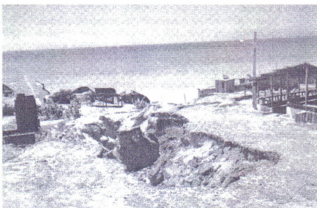
Buraco na rua produzido pela erosão pluvial...
