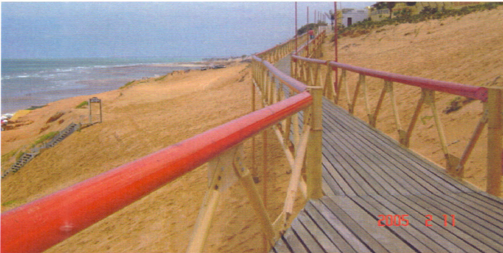
(Fig. 5) Vista da plataforma montada durante a “requalificação”, vista privilegiada e acesso facilitado para a praia.
