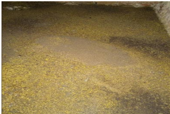
Figura 7 – Aspecto de guano em camadas, coletado de colônia de morcego onívoro
