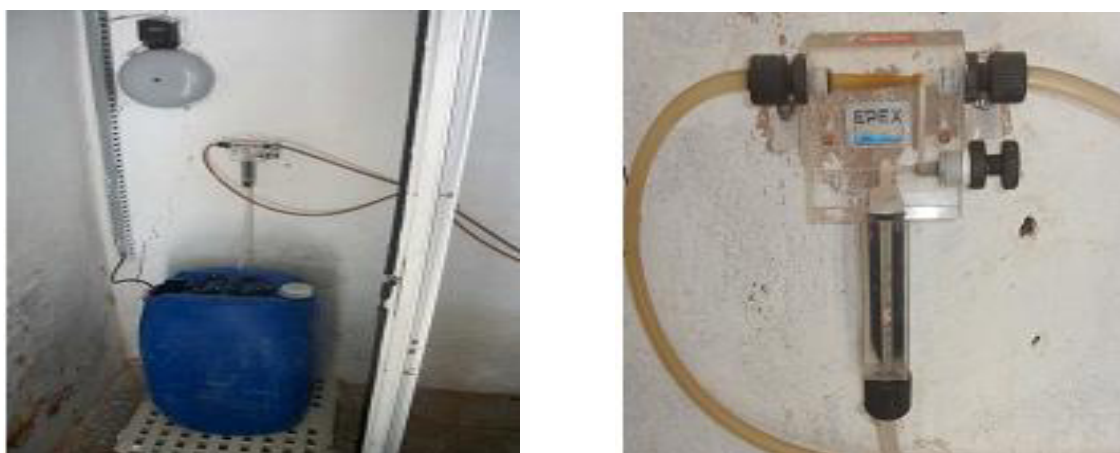
Figura 4 – Dosador automático de cloro, que abastece todas as caixas d'água da indústria INTERFRIOS.
