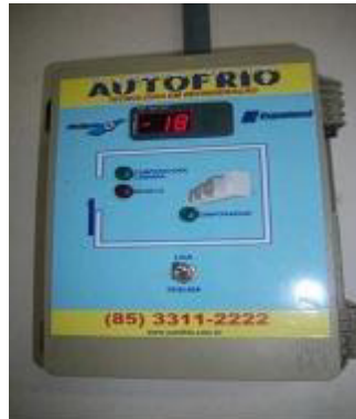
Figura 11 – Registrador digital de temperatura no interior da câmara de estocagem da INTERFRIOS.
