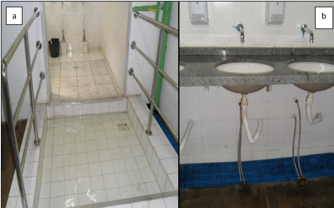
Figura 5 – Pedilúvio com solução de quaternário de amônio e lavatórios com torneiras com acionamento por pedais na INTERFRIOS - Intercâmbio de Frios S.A., em Fortaleza, Ceará.
