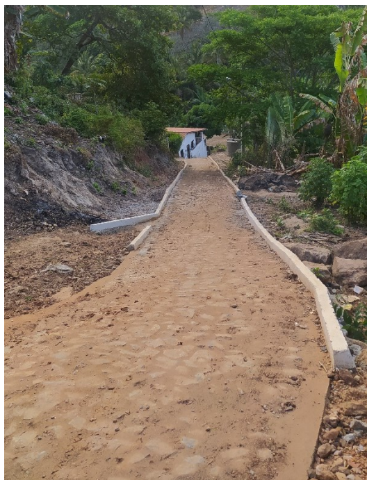
Imagem 10 – Viela de barro que dá acesso à comunidade rural Caboclos.
