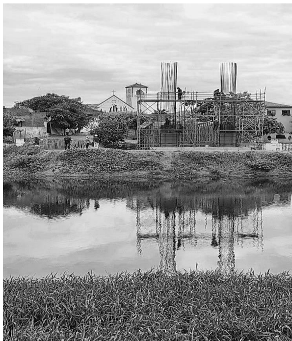
Figura 30 - Concretando o Rio Acaraú, em Sobral, 2020
