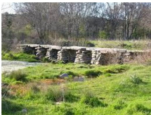
Figura 1: Ponte em Laje de Pedra, Junciana-Espanha.
