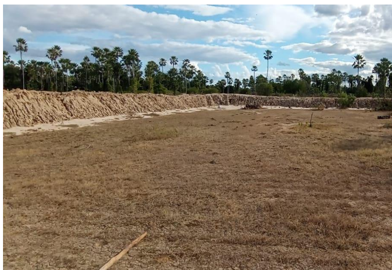
Figura 11 – Construção de um dos reservatórios de carcinicultura da fazenda.
