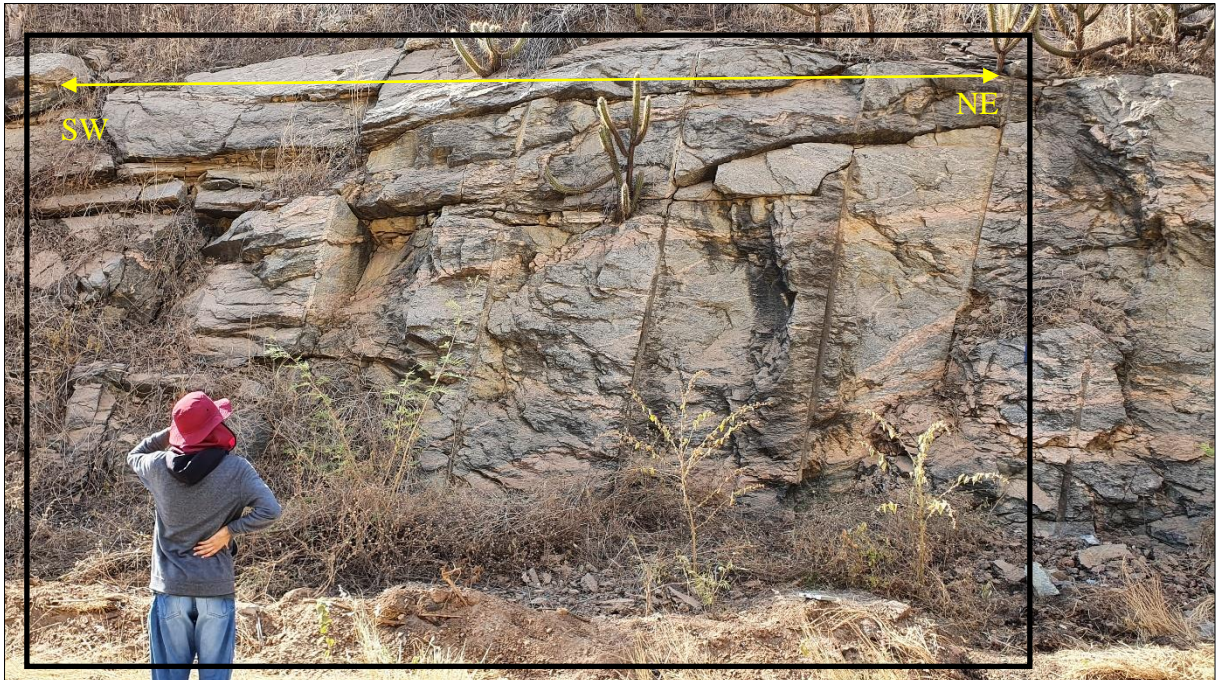
Figura 34 - Seção TS3 do talude noroeste
