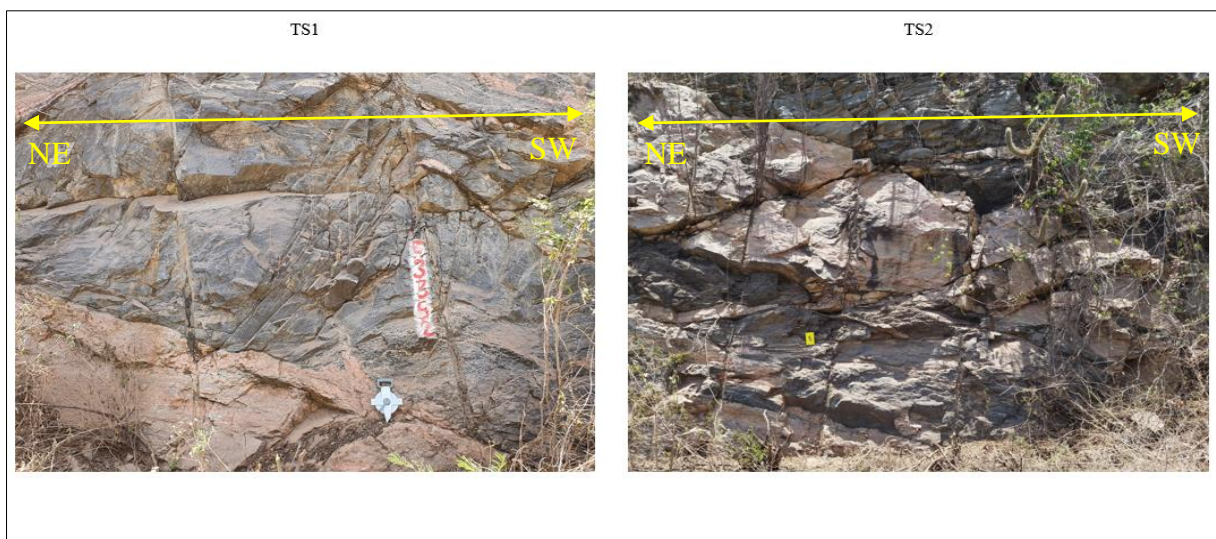
Figura 36 - Litologia e características da superfície do talude sudeste para as seções TS1 e TS2
